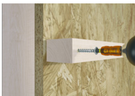
Befestigung einer Installationsebene
