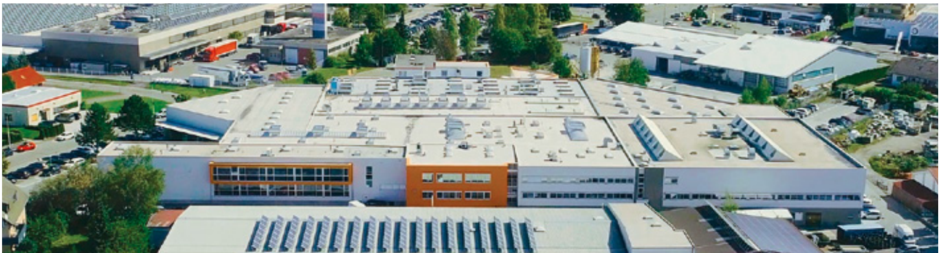
Das Hauptwerk in Schramberg-Sulgen
